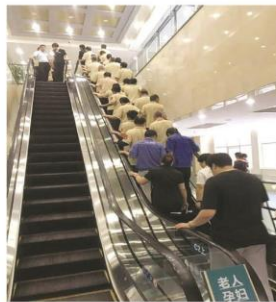
物业测试电梯
